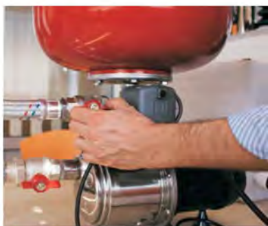
1) Chiudere l'impianto idrico in mandata
