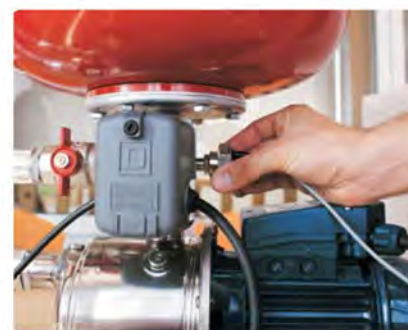
5) Installare il sensore di pressione
