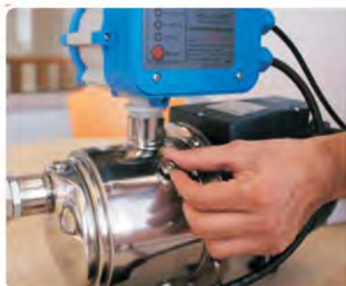
4) Togliere il tappo di sfiato aria posto sul corpo della pompa
