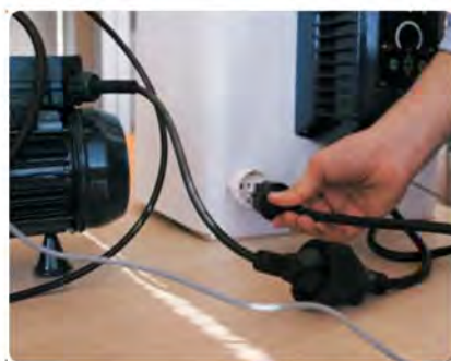
7) Collegare l'inverter alla rete di alimentazione elettrica
