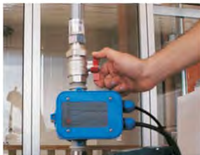
1) Chiudere l'impianto idrico in mandata
