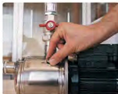
2) Togliere il tappo di sfiato aria posto sul corpo della pompa
