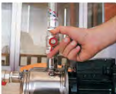
1) Chiudere l'impianto idrico in mandata
