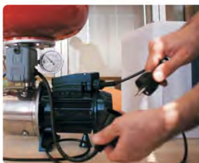
3) Scollegare il cavo elettrico che alimenta il pressostato
