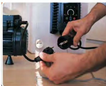
6) Connettere elettricamente l'Inverter all' elettropompa
