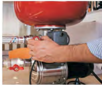
1) Fermer l'installation hydraulique en refoulement
