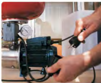
3) Débranchez le câble électrique qui alimente le pressostat
