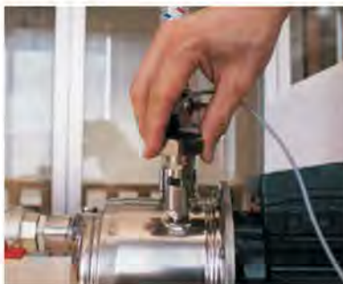
3) Installer le capteur de pression
