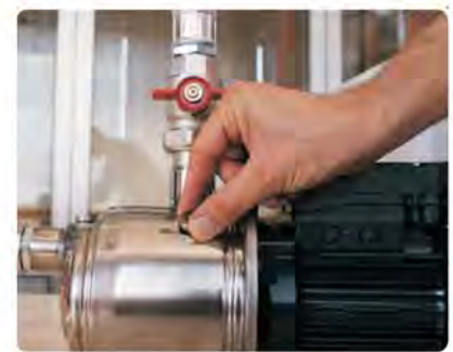
2) Enlever le bouchon d'échappement de l'air qui se trouve sur le corps de la pompe
