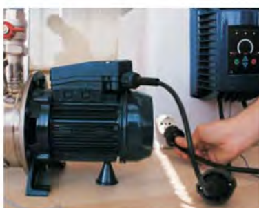
7) Raccorder l'inverter au réseau
